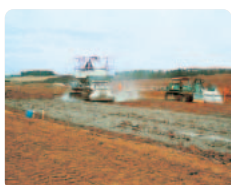
『ユースタビラー』の施工状況
