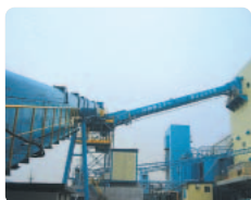
稼働中のエア浮上コンベヤ
