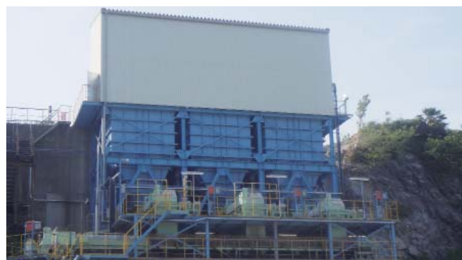
合理化工事・定量供給設備(伊佐セメント工場)
