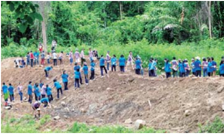
堰と堤防を築く作業
