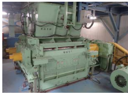
破碎設備 (伊佐セメント工場)
