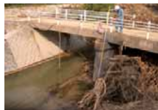
災害地での測量
