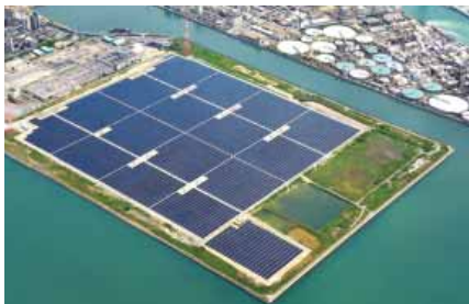
メガソーラー発電所 (ユーエスパワー(株))
