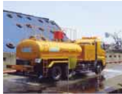
沖の山コールセンターにおける発じん・飛散防止の散水
