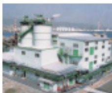
焼却灰セメント原料化プラント
