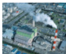
「カルブリードSII」を使用している焼却場
