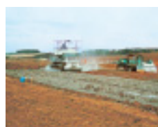
「ユースタビラー」の施工状況
