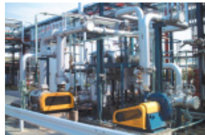
1,3ブタジエン燃焼のための分離設備
