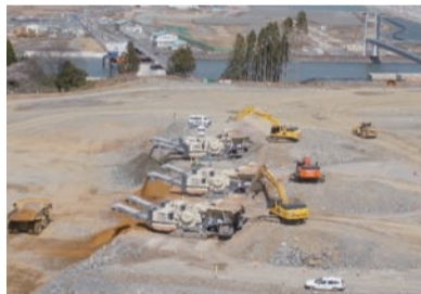
岩手県陸前高田市の復興工事現場では、当社の移動式破砕機が最大で6台使用されました。山から切り出した原石を砕き、住宅地の造成に役立てられました。
