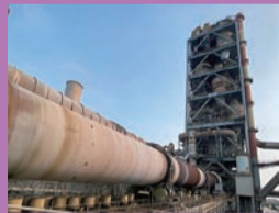
セメント原料などを高温で焼いて化学反応させるロータリーキルン
