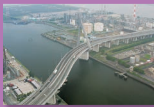
カーブが美しい宇部スカイロードの栄川運河橋(2011年完成)
