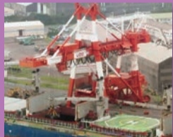
大型船から石炭などを荷揚げするクレーン
