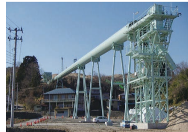
岩手県山田町の住宅地高台移転事業では、当社のベルトコンベヤが山の土砂を数キロにわたって運び、津波の心配がない高台の住宅地づくりを支えました。
