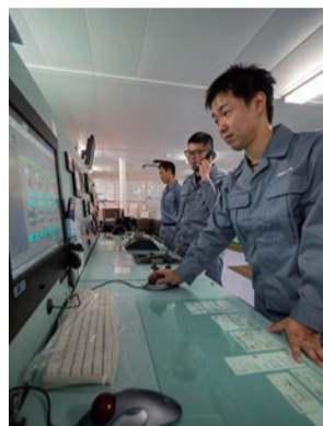
機関制御室では機関士が船橋にいる機関長と連絡を取りながら運転操作を行います。
