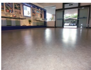
PUDを使用して施工された床面
