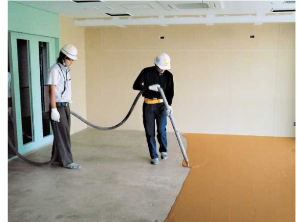
【セルフレベリング材 施工】
