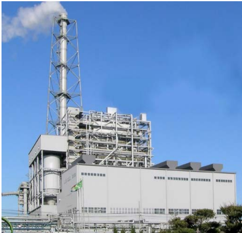
【216MW IPP発電所】
