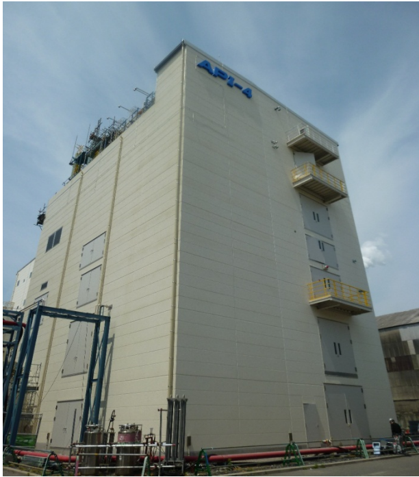
【第四医薬品製造設備】
