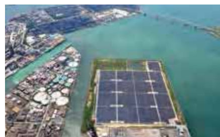
メガソーラー発電所
