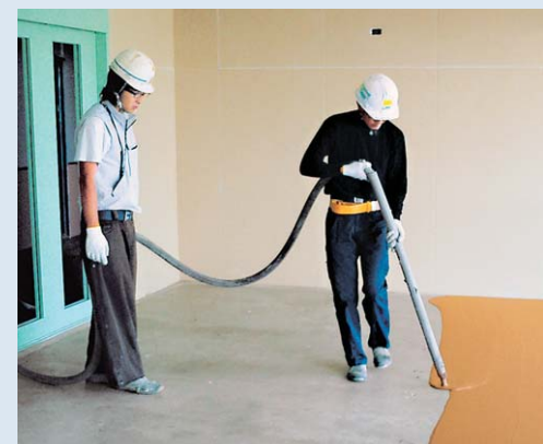
セルフレベリング材の施工例
