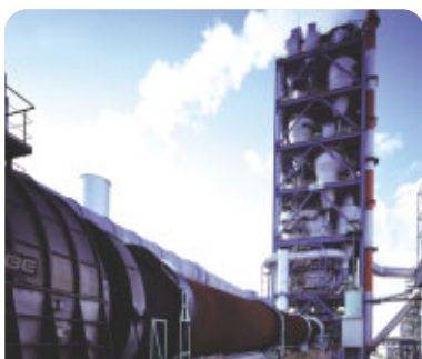
宇部セメント工場のNSPキルン
